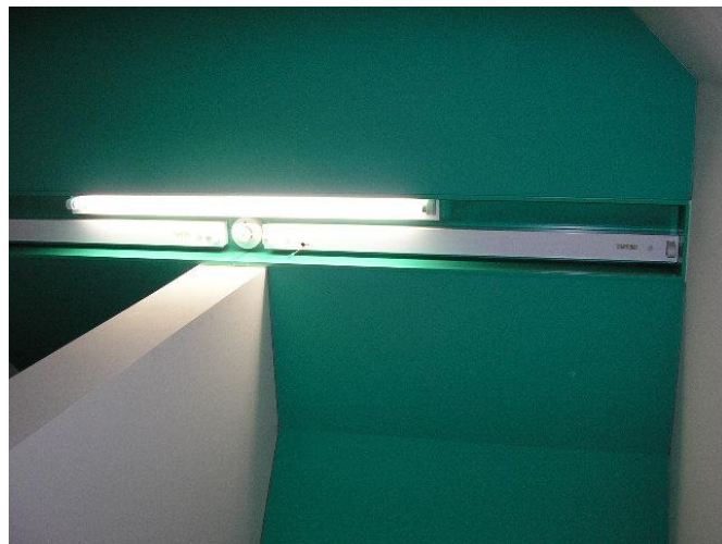
非常階段の照明間引き 利用頻度の低い非常階段の照明を間引きし 年間3tの削減
