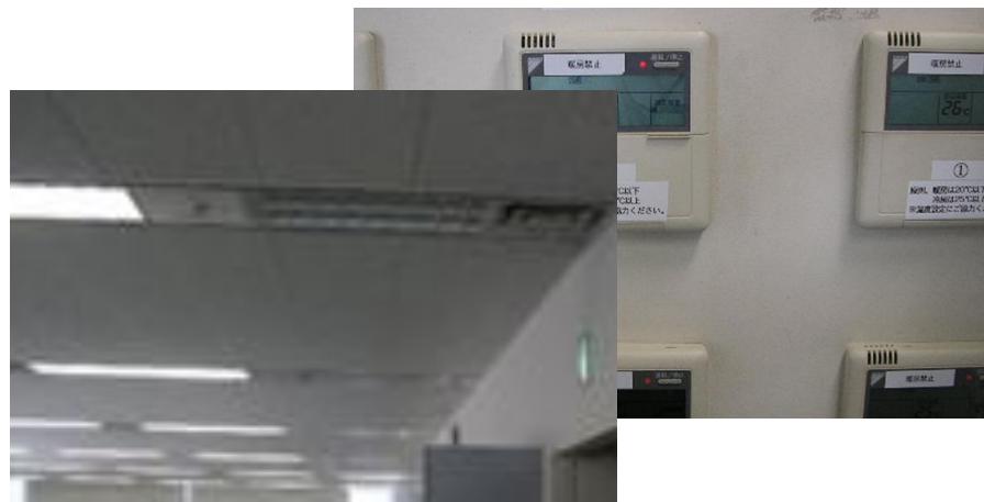
テナント自身の対策 テナントへの呼びかけに応じて、テナントが自主的に専用部の空調リモコンに温度設定シールの貼付や事務所内の照明間引きを実施
