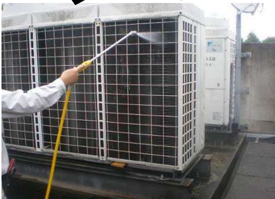
写真：フィンコイル洗浄の実施風景
