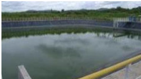
雨水貯留池 (カーボン工場, タイ)
