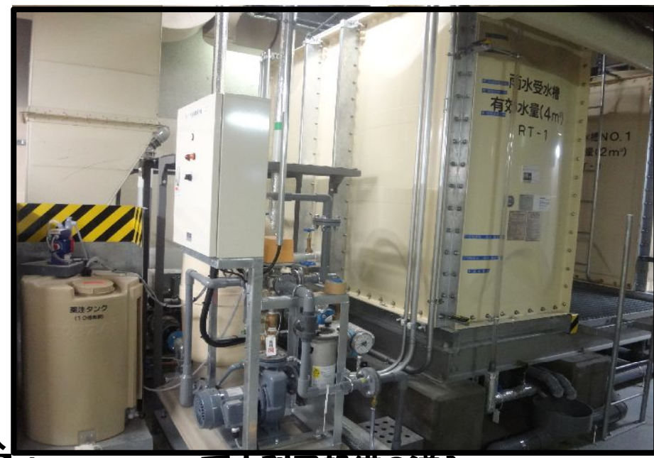
雨水利用設備の導入
