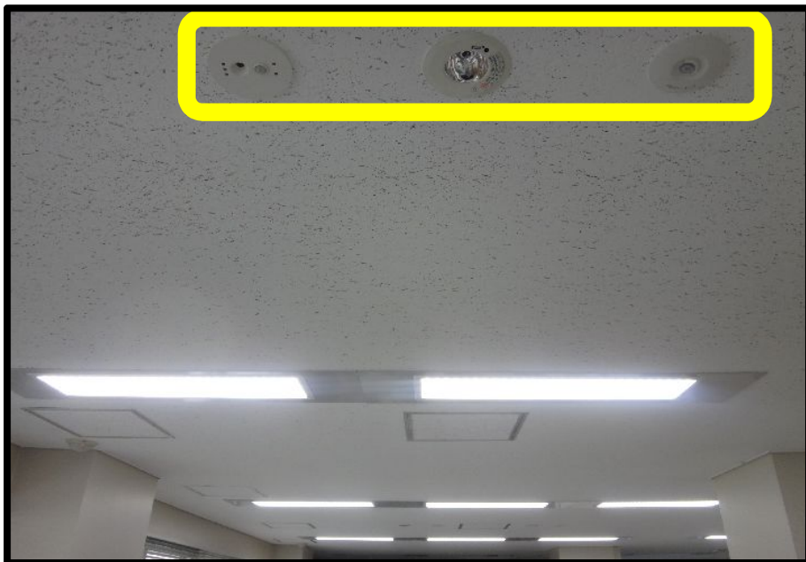
高機能センサーによる調光・点消灯制御
