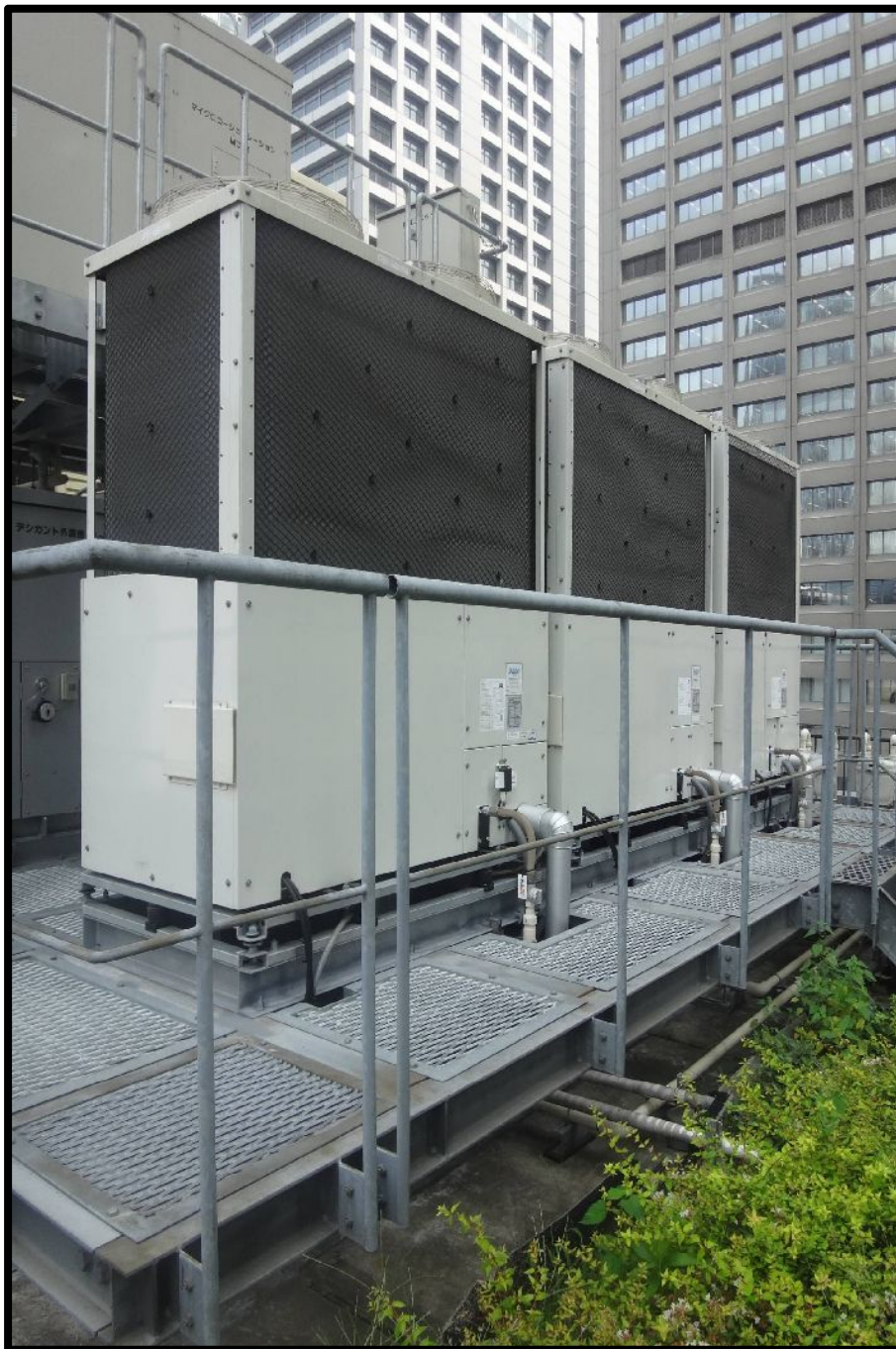
(インテリア系統)ガス空調の採用
