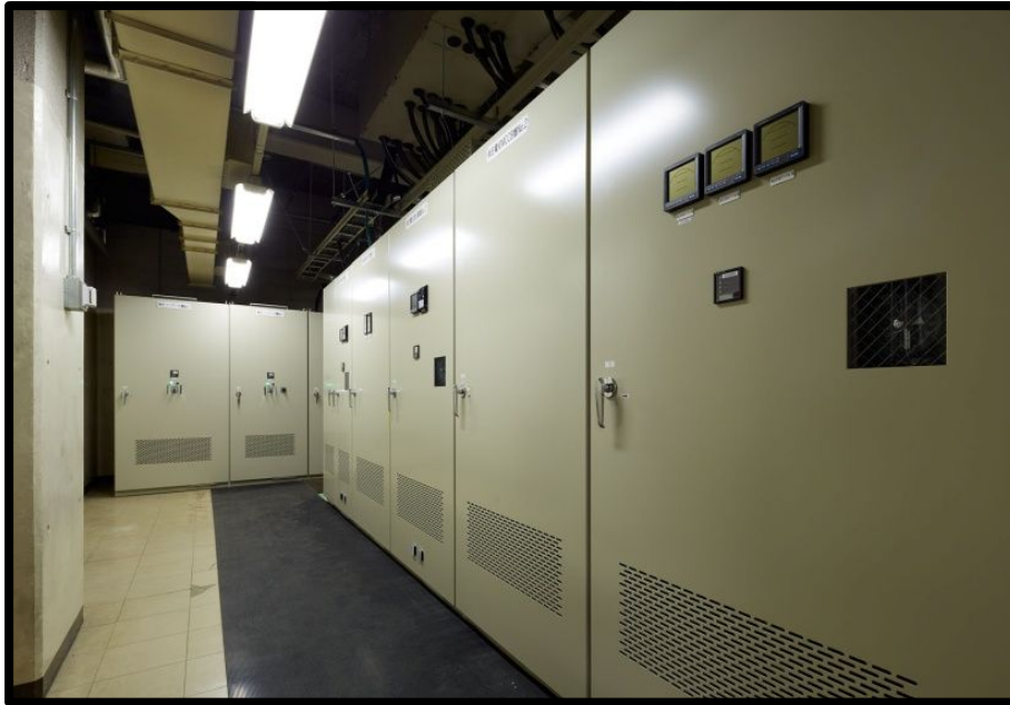
受変電設備の更新
