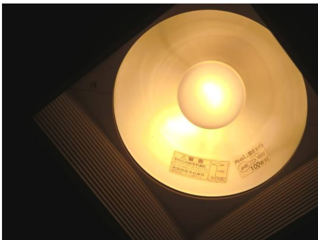
クリプトンランプを電球形蛍光灯に交換 60W→10W
