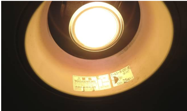
ハロゲンランプをLEDに交換 75W→10W
