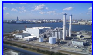
東京ガス扇島 81万kW
