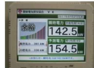
写真Ⅲ-4-1 デマンド監視装置の表示例
