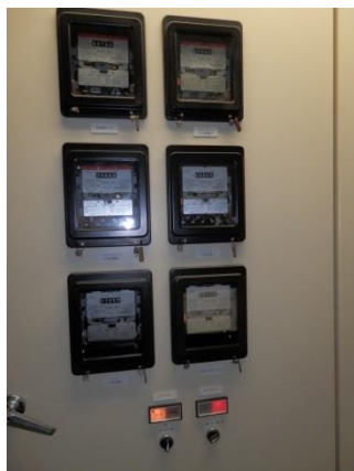
既存電気メータ
