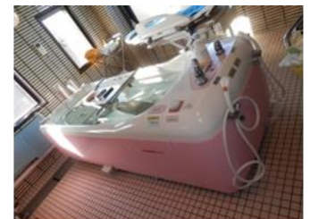
水漏れしてる水栓
