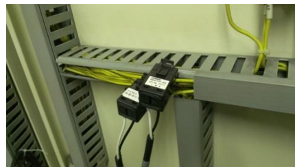
自動計測の取り付け
