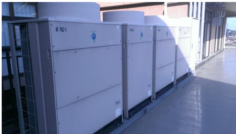
対象の空調機（ビルマルチエアコン）
