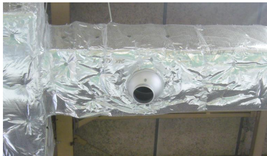
ダクト+吹出口ルーバー
