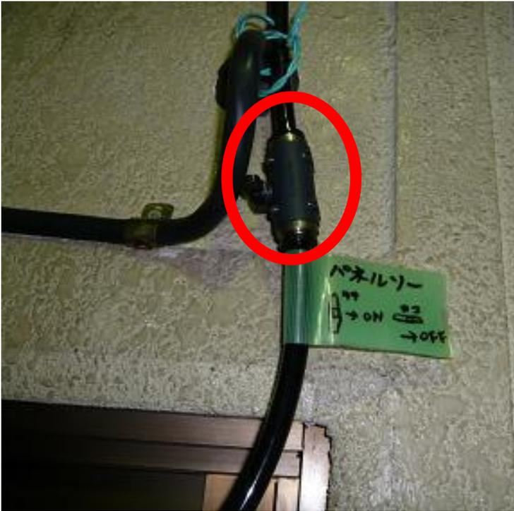
常時使用しない機器への圧縮空気の供給は損失につながる。
