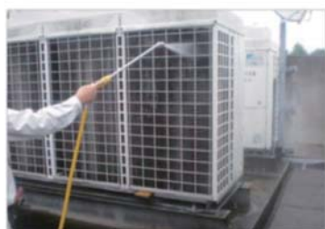
室外機フィンの洗浄状況
