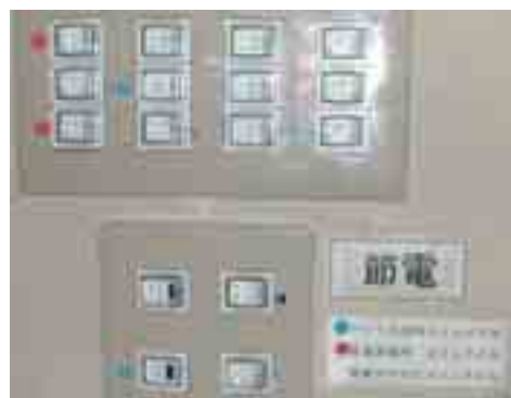
照明スイッチにラベル取り付け例
