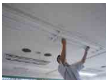
明る過ぎる照明を間引き消灯
