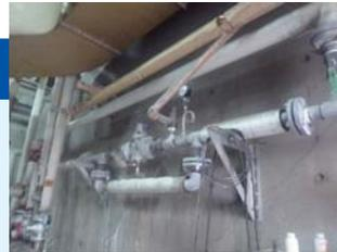
蒸気配管、バルブの未保温部分
