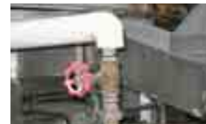
保温されていない配管・バルブ部
