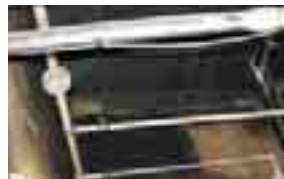
保温されていない配管・バルブ部
