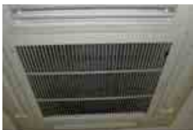
空調室内機:目詰まり有
