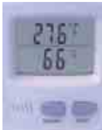
売場に温度計の設置
