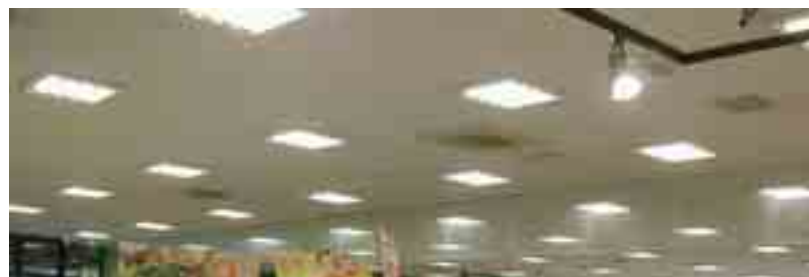
売場の天井照明の例
