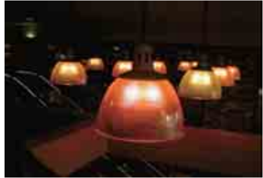
400W天井灯による照明の例(改善の余地あり)
