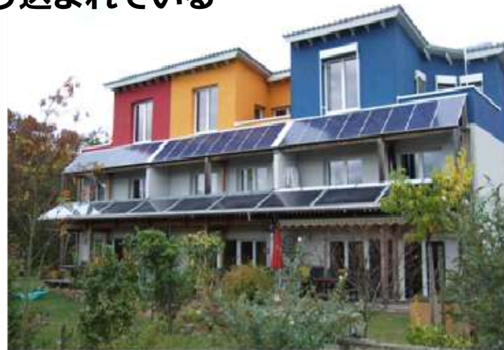
庇に設置した集熱器
