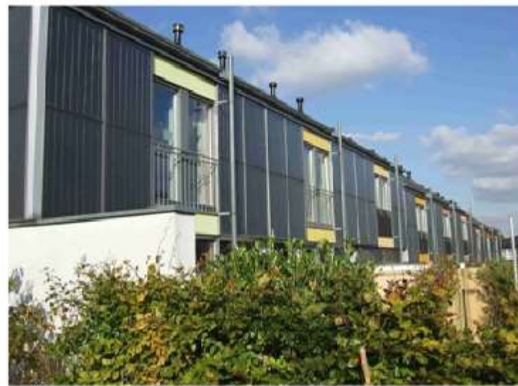
壁面設置の集熱器
