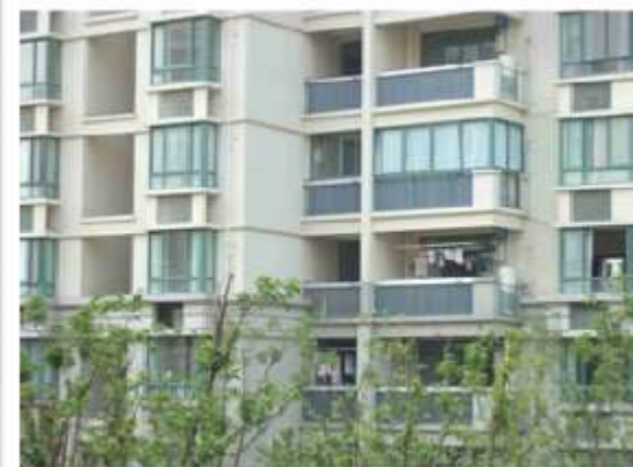
バルコニー設置
