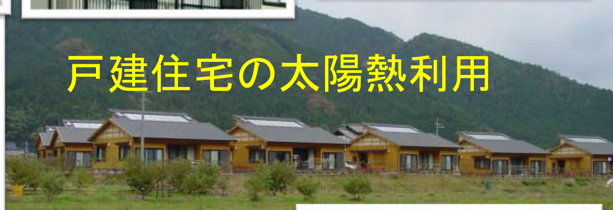
空気集熱式太陽熱暖房給湯システム
