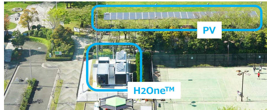
H2One™の接地面積はPV含めてテニスコート1面分
