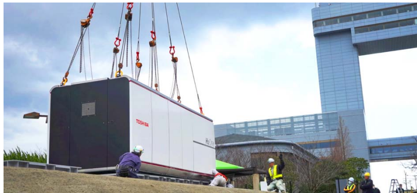
川崎マリエンでの設置風景
