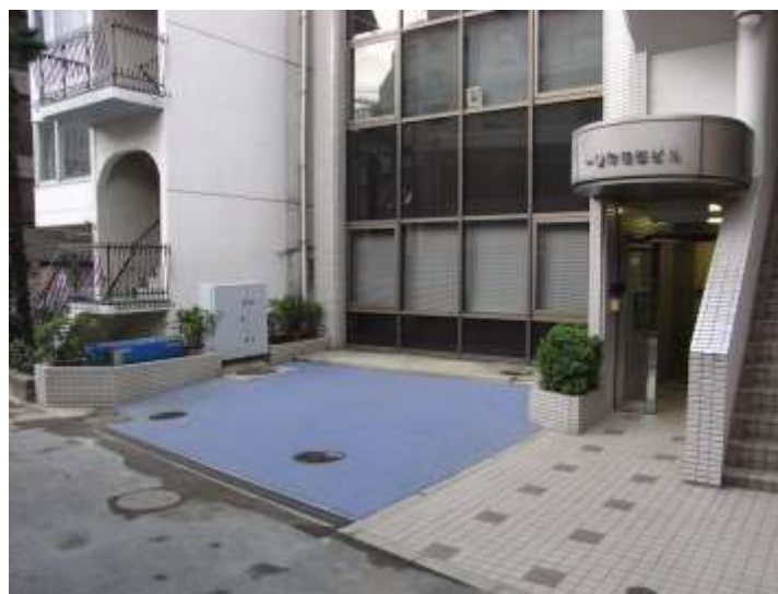
地中熱交換器を埋設した駐車場
