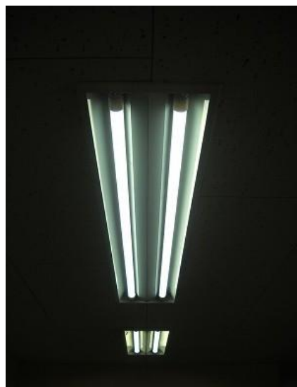
蛍光灯型LED照明 (20W × 2本 = 40W) 床上1m 約980ルクス
