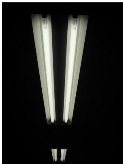
高効率32W Hf蛍光灯 (45W × 2本 = 90W) 床上約1m 約1030ルクス
