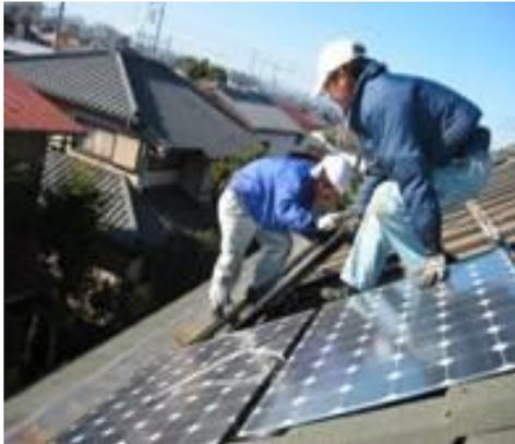
売電力が減少したとことでシステム不調を疑う。設置業者へ連絡。発電量は「その程度が妥当」と言われ2年経過。2003年9月PV-NetのPV健康診断を受診。設置当初の50%程度の出力であることが判明。PV健康診断の結果と共に設置業者、メーカーへ連絡し調査依頼。数回の調査後パネルの全交換が決まる。
