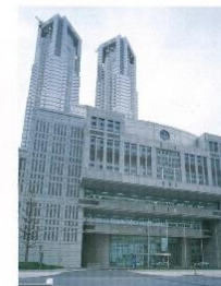
■ 東京駅前総合ビル 7F空調設備向給排水工事
