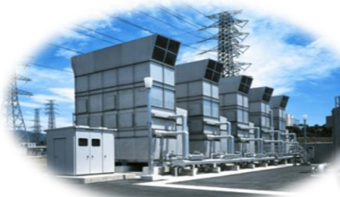
変圧器用冷却塔
