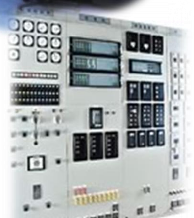
変電所 監視制御盤
