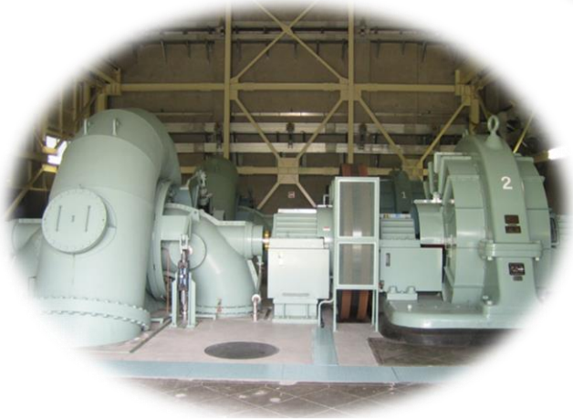
水車・発電機、制御盤
