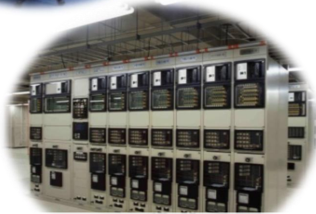
変電所 インターフェース盤
