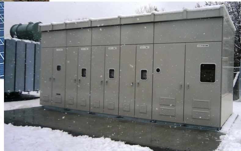
<22/33kV 気中キューピクル>
