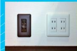
非常用コンセント (屋外設置パワーコンディショナの例)
