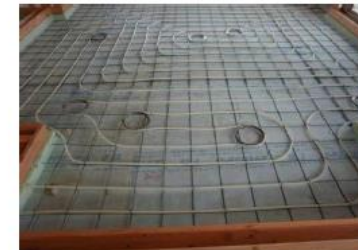
床暖房配管(蓄熱コンクリート内部) *
