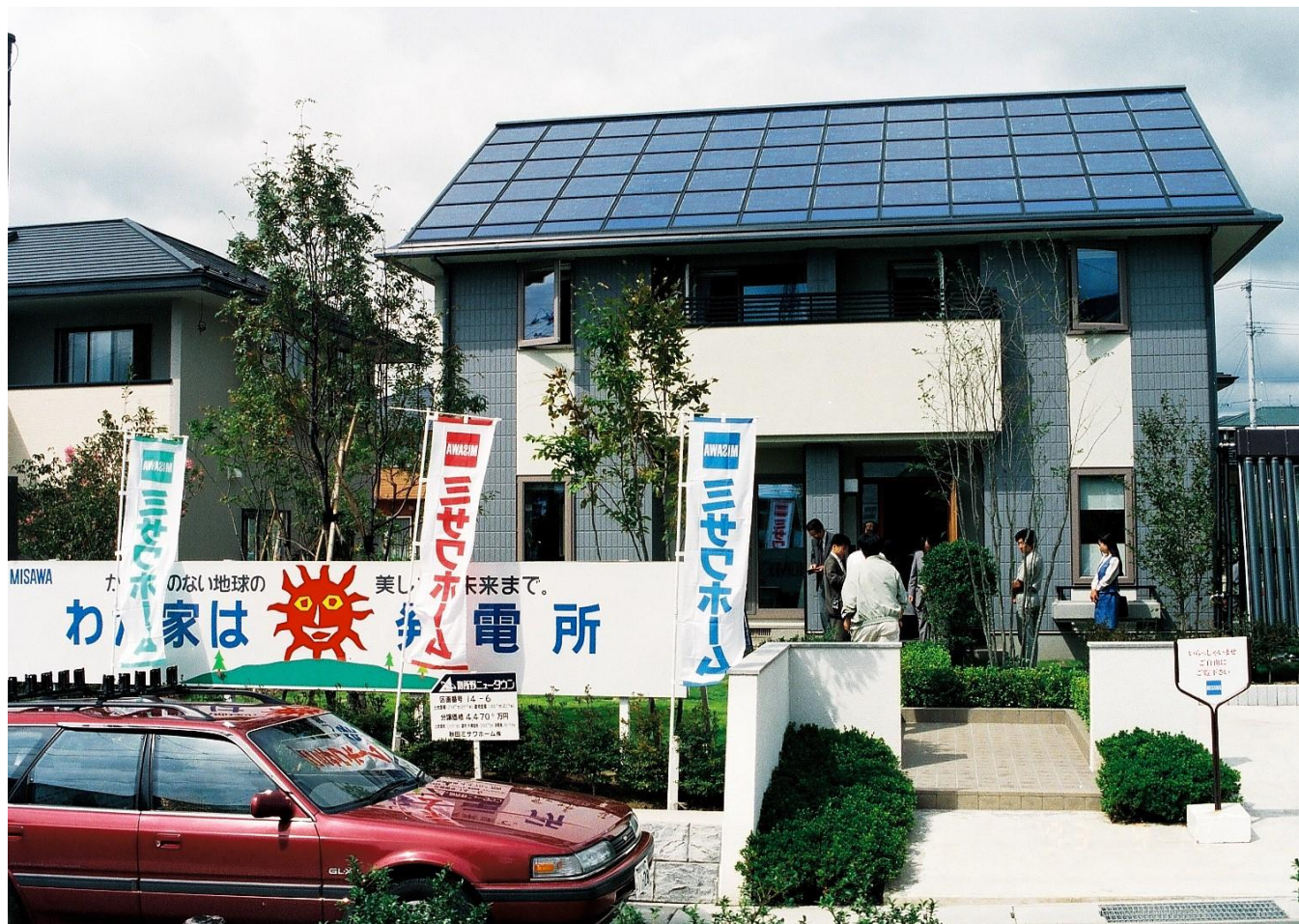
太陽光発電、太陽熱給湯を設置した高断熱住宅 (秋田市近郊, ミサワホーム)
