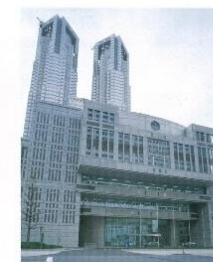
■東京駅前総合ビル その他空調設備機器工事
