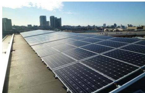
太陽光ハイブリッドパネル設置状況
