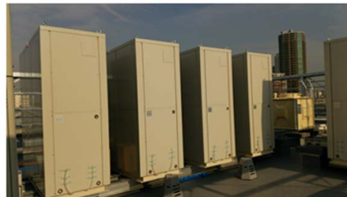
タンクユニット（1,500L×6基）
