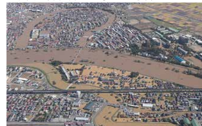
令和元年台風第19号による水害
