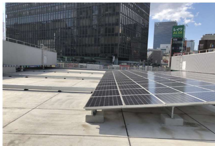
写真1.太陽光発電設備
