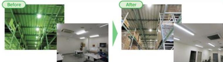
弊社が借りている2階建て延べ床面積4300㎡の倉庫は、築25年と経年劣化が進んでいました。水銀灯が設置されている2階は有効高が8mと高く、一日中暗い中で作業を行う環境。1階では生鮮食品を扱い365日稼働するため、電気代に負担をかけるなど課題を抱えていました。しかし設備改修は、オーナーとテナント間の動機やタイミングが一致せず思うように進まないのが現実…
