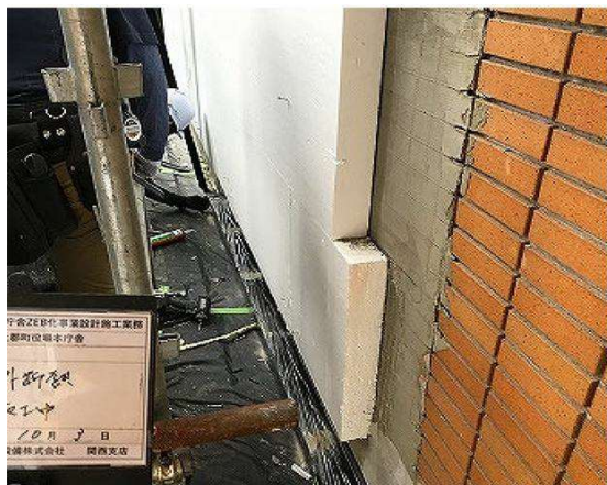
③ 断熱材の貼り付け 70mmポリスチレンフォーム
