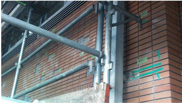
① 外周部の既存外壁を調査 既存タイルの落下防止処理
