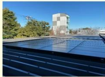
印刷工場の屋根に設置した太陽光発電
