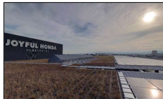
屋上部太陽光発電パネルと緑化部分 （将来的な太陽光設置検討エリア）
