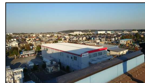
将来的に太陽光発電システムの設置を検討している隣接工場建屋
