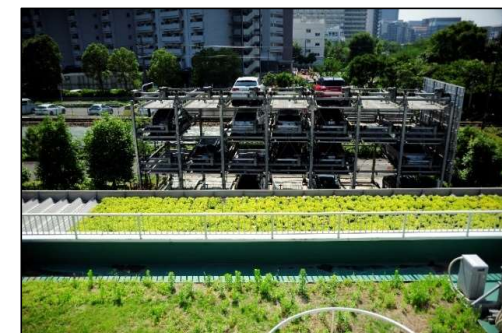
蓄電池（右）と建物ひさし部分に移された屋上緑化
