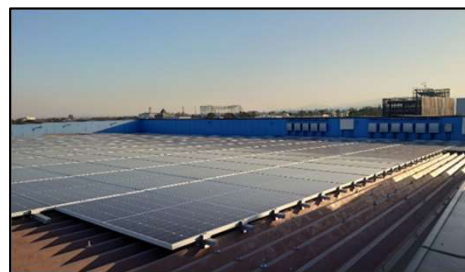
本社工場設置の太陽光発電システム
